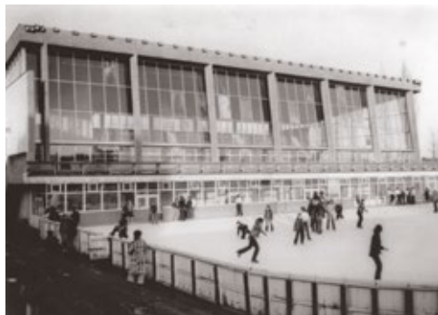
In 1965 gaf de gemeente Sint-Lambrechts-Woluwe architect Isia Isgour de opdracht om de plannen te tekenen voor een openluchtjispiste. Het water op de piste werd bevroren met 21 km buizen gevuld met ammoniak. (© vzw Poseidon)
