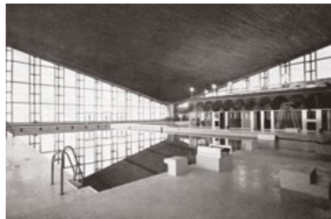
Het Longchamp-zwembad werd in 2008 door een brand geteisterd en nadien grondig gerestaureerd, waarbij de oorspronkelijke bekleding van het plafond in latwerk van cederhout werd verwijderd. La Technique des Travaux nr. 345, januari 1974. (© GOB - DCBSO)
