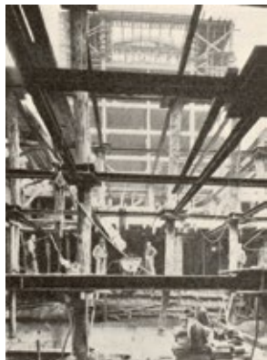
Baden van Brussel. De stabiliteit was de grote uitdaging van de werf: er waren 482 Franki-palen nodig voor de funderingen. La Maison , nr 2, februari 1954 – p. XXXIII. © GOB – DCBSO
